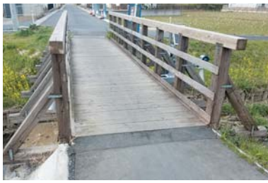
幅員約1.5メートルの橋(浜田町)
