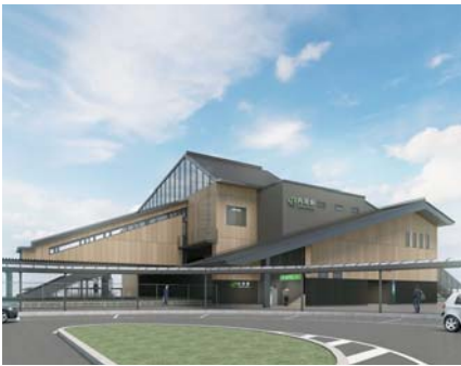
整備完了後の内原駅南口(パスス)
