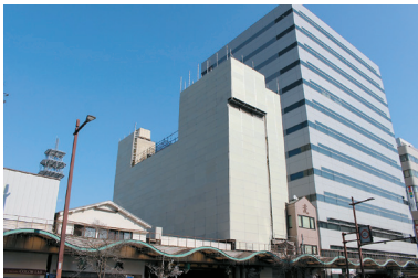
行政代執行により外壁撤去を行ったビル(南町)
