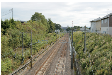
(仮称)新岡田橋こ線道路橋新設工事箇所
