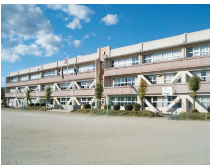
千波小学校(屋上の防水改修工事を予定)
