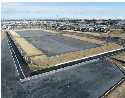
整備中のサッカーグラウンド
