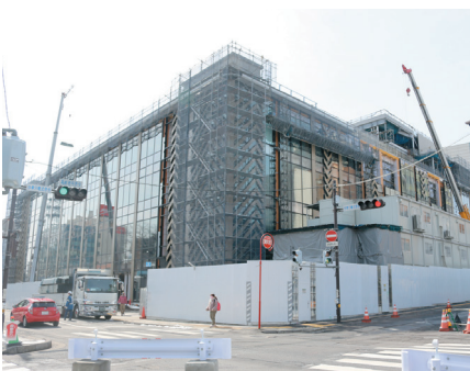
建設中の新市民会館(泉町1丁目)
