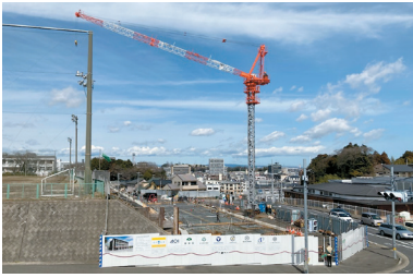
建設中の南消防署
