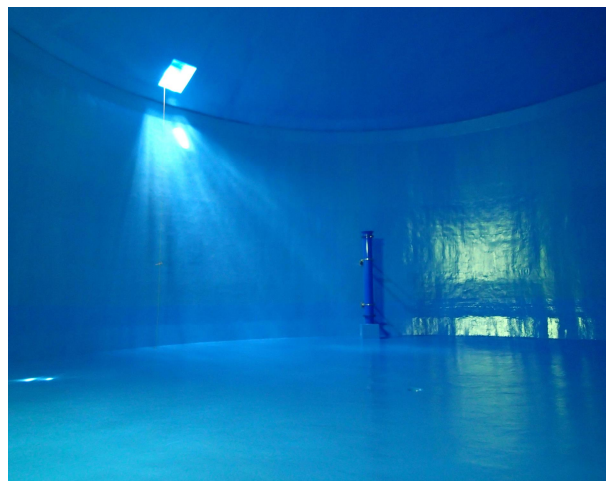
図 4-3-7 修繕後の配水池内部
