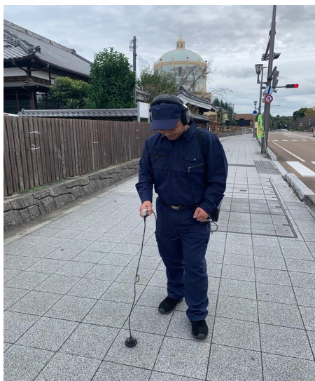
図 4-5-4 音聴による漏水調査の様子
