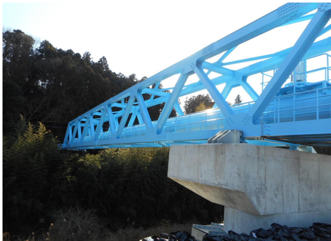
図 4-3-6 水管橋（田野川第一水管橋）
