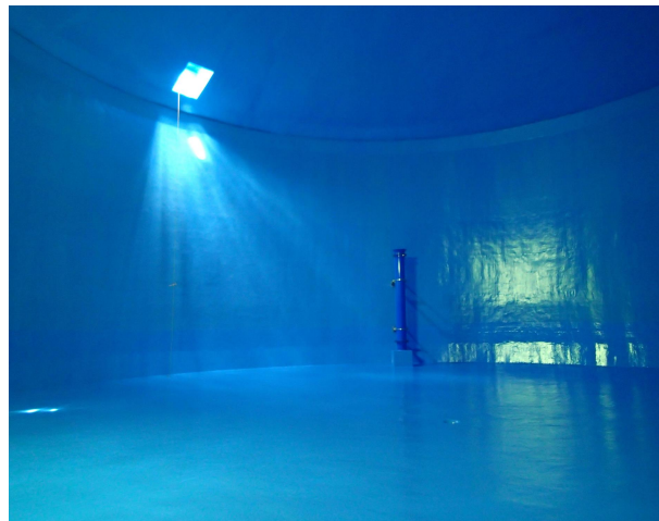
図 4-3-7 修繕後の配水池内部
