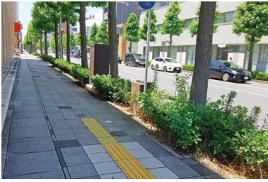
点字ブロックが途切れている歩道
