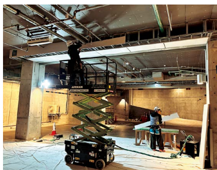
市民会館地下駐車場天井部の改修工事
