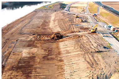
那珂川左岸中河内町上流地区河道掘削工事
