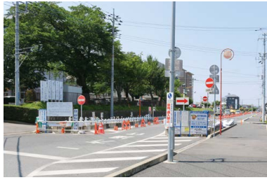
第一中学校前の工事現場
