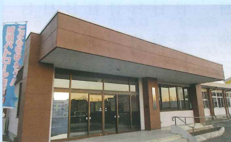
長寿命化型改修完成時の市民センター
