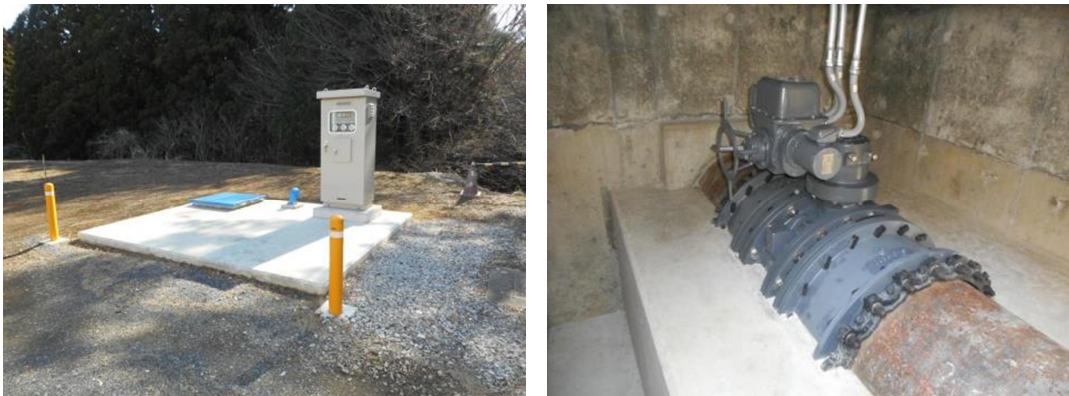
図 4-17 開江浄水場流量調節弁設置状況
