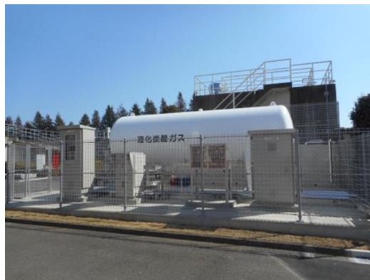
図 4-23 楮川浄水場 薬品注入（酸処理）設備設置状況
