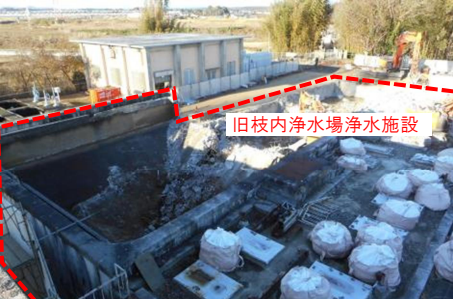
図 4-6 新取水導水施設整備状況（旧枝内浄水場浄水施設解体）
