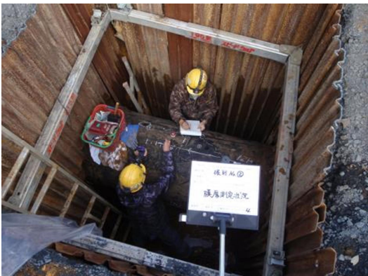
図 4 -10 開江系導水管管体調査状況
