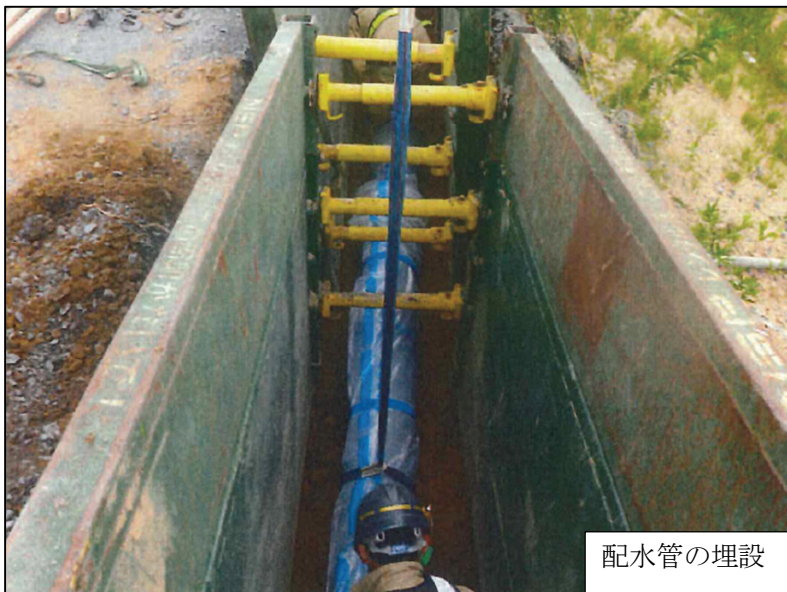
仮配水管布設
