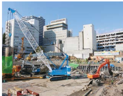
再開発の工事現場(三の丸地区)
