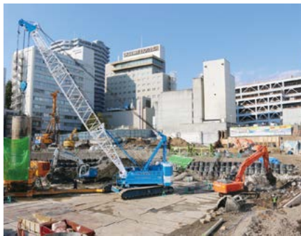
再開発の工事現場(三の丸地区)
