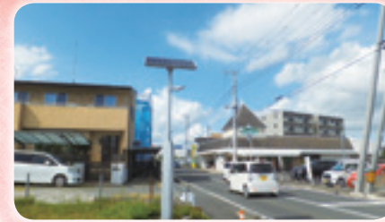
LED防犯灯設置
