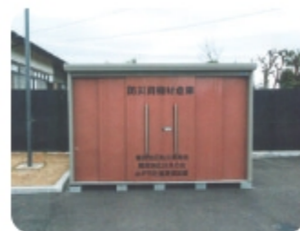
鯉淵地区防災委員会倉庫
