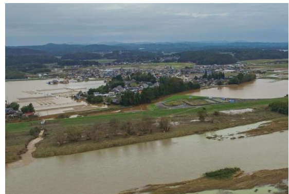
図3-7 水戸市内の河川氾濫による被害 （令和元年東日本台風・水戸市撮影）
