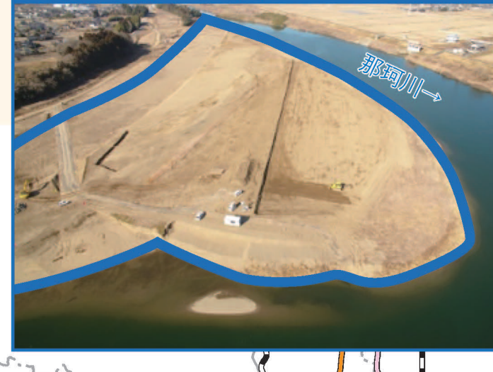
④河道掘削 （水戸市渡里町地区）
