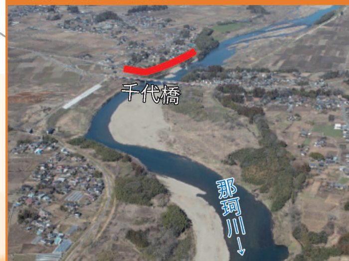
⑦堤防整備 （城里町下坪地区）
