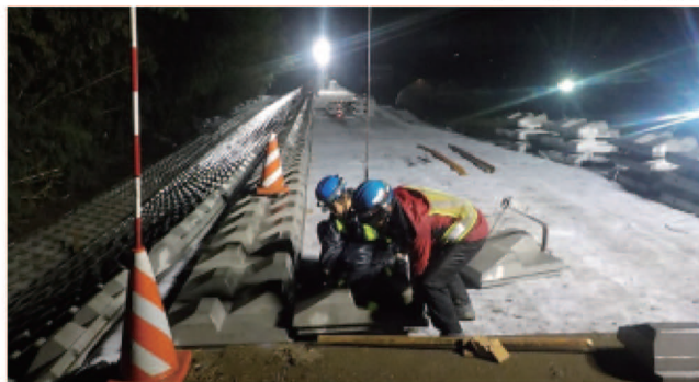
野口地区の緊急復旧の様子(那珂川左岸40k)
