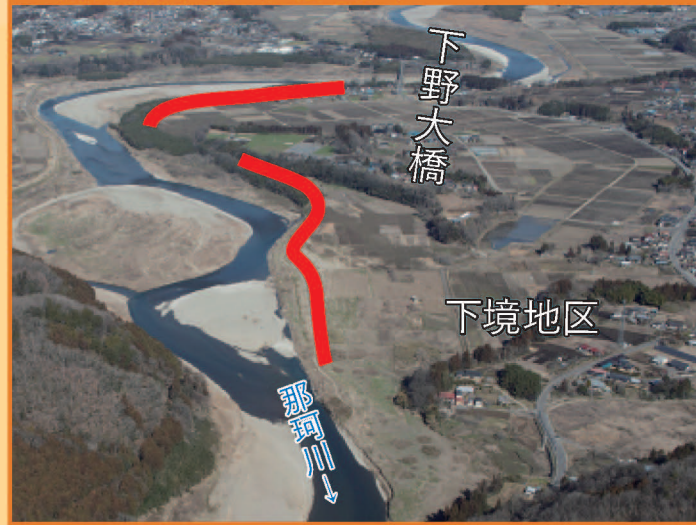
①堤防（霞堤）整備 （那須烏山市下境地区）
