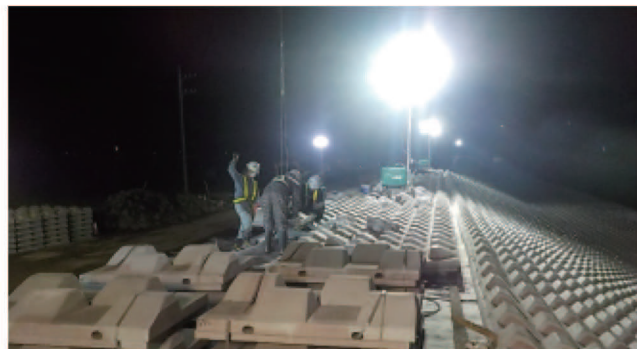
下江戸地区の緊急復旧の様子(那珂川右岸28.6k)
