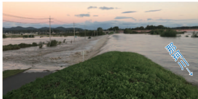
下江戸地区の越水状況
