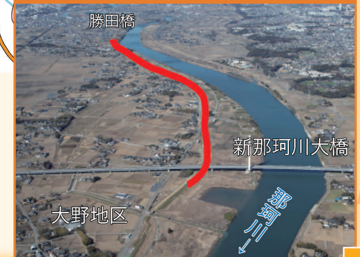
⑨堤防整備 （水戸市大野地区）
