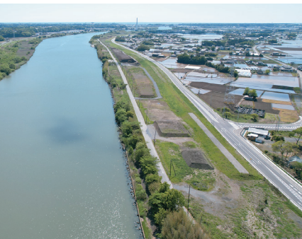
築堤が進む上大野地区
