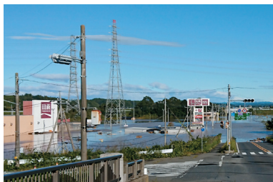
令和元年水害時の水戸北IC付近
