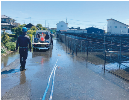
6月の大雨による被害の現場(酒門町)
