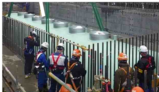
軽油貯蔵タンク 地下設置
