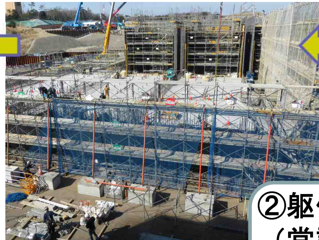
鉄筋設置及び コンクリート打設
