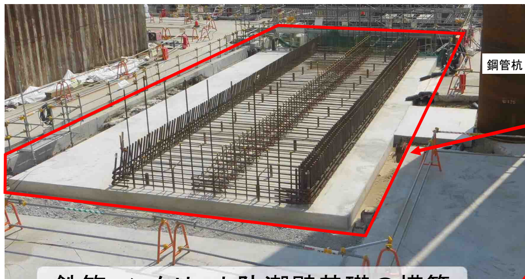
鉄筋コンクリート防潮壁基礎の構築
