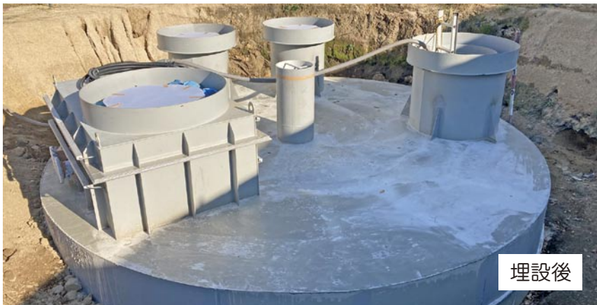
内径6.0m、高さ3.75m。写真は施工中のもの
