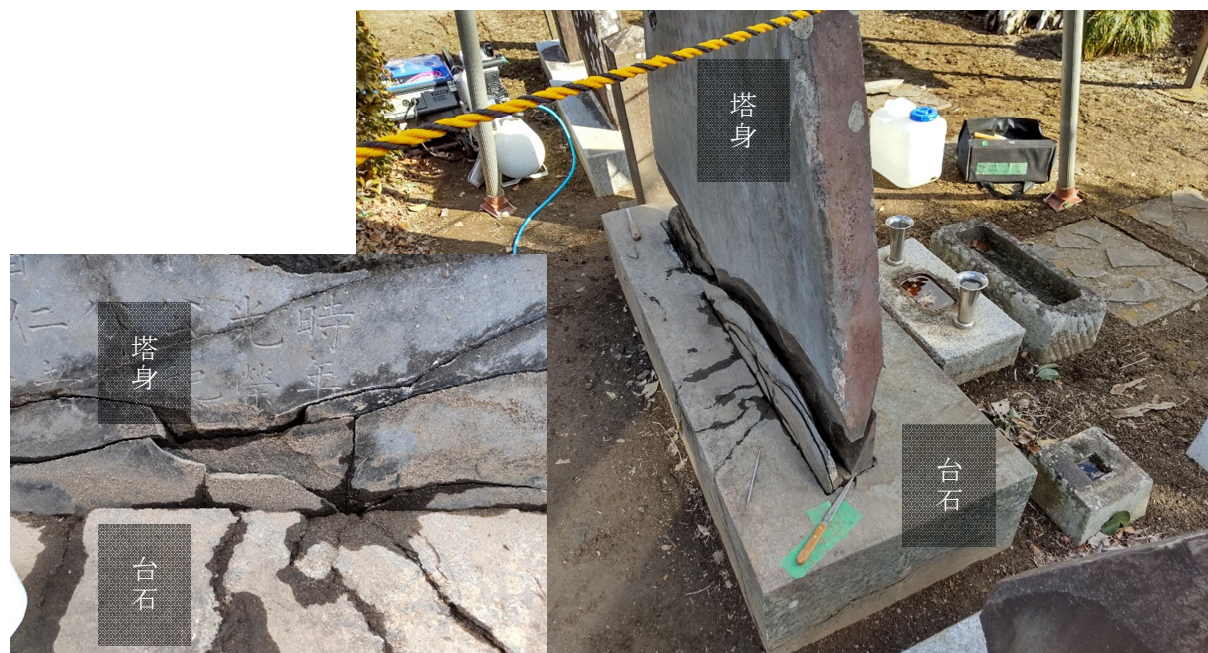
会沢正志斎の墓 墓石台石の割れの状況 (塔身修理中の写真)
