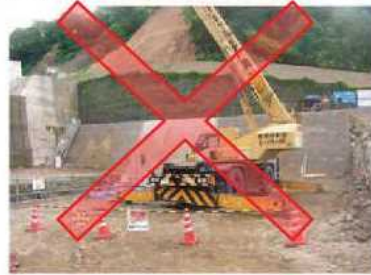
排ガス・低騒音機械確認写真
