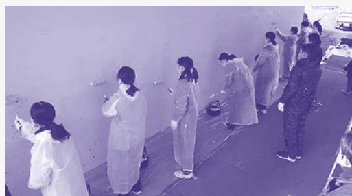
トンネル壁面のらくがき消し作業
