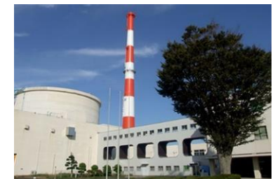
高速実験炉「常陽」
