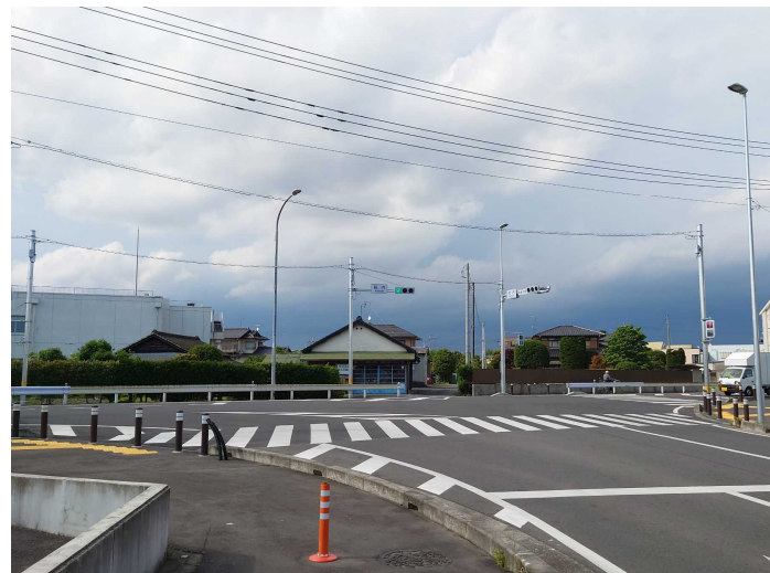
No.24 (株)綿正工務店 都市計画道路3・4・149号赤塚駅西線国道50号交差点道路改築工事
