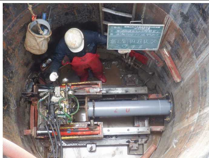
No.12 (有)シン建設 国補公共下水道渡里処理分区枝線(4-2工区)工事
