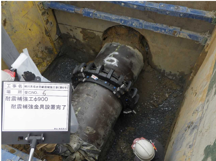
No.1 秋山・海老澤JV 栢川系導水管耐震補強工事(第6号)
