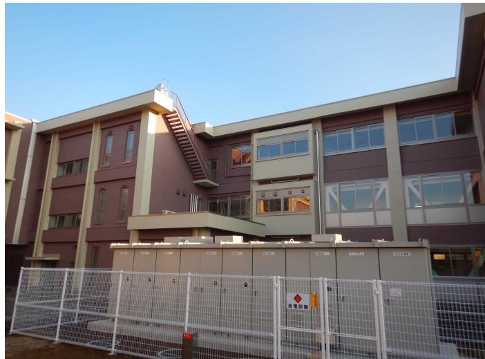
No.15 泰明・川崎・興和JV 水戸市立渡里小学校長寿命化改良電気設備工事
