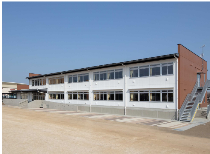
No.8 昭和・豊島・大将JV 水戸市立笠原小学校校舎増築(Ⅱ期)工事
