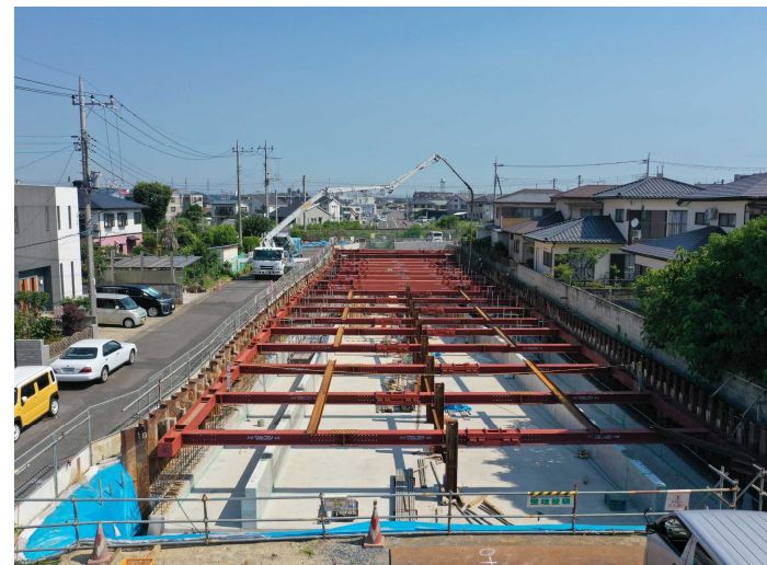
No.20 豊島・綿正JV 都市計画道路3・4・149号赤塚駅西線 道路新設(3工区)工事
