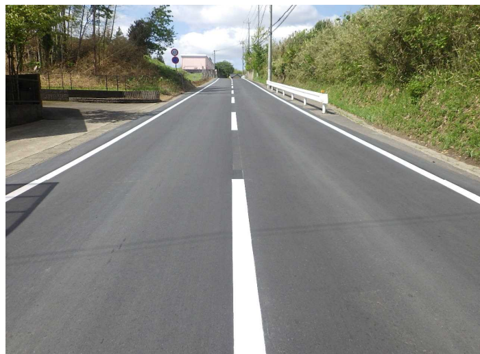
No.7 (有)城建工業 幹線市道8号線舗装補修(2工区)工事
