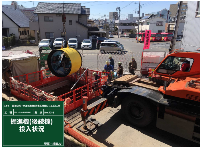
No.13 菅原・横田JV 国補公共下水道城東第1排水区枝線(2-1工区)工事
