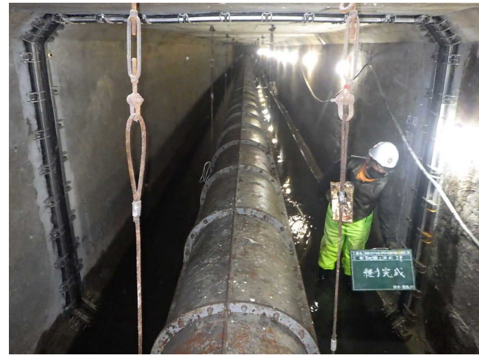
No.4 株木・豊島JV 国補公共下水道那珂川遮集幹線耐震補強工事
