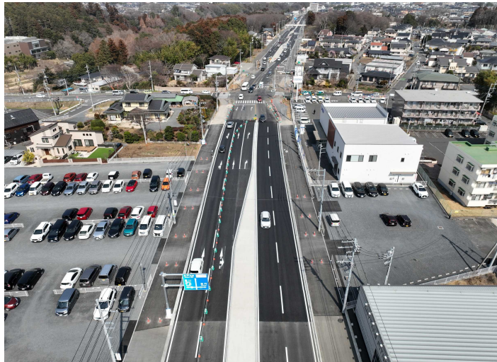
No.17 田口建・横田JV 都市計画道路3・3・16号梅香下千波線(畑中工区) 道路改築(2工区)工事
