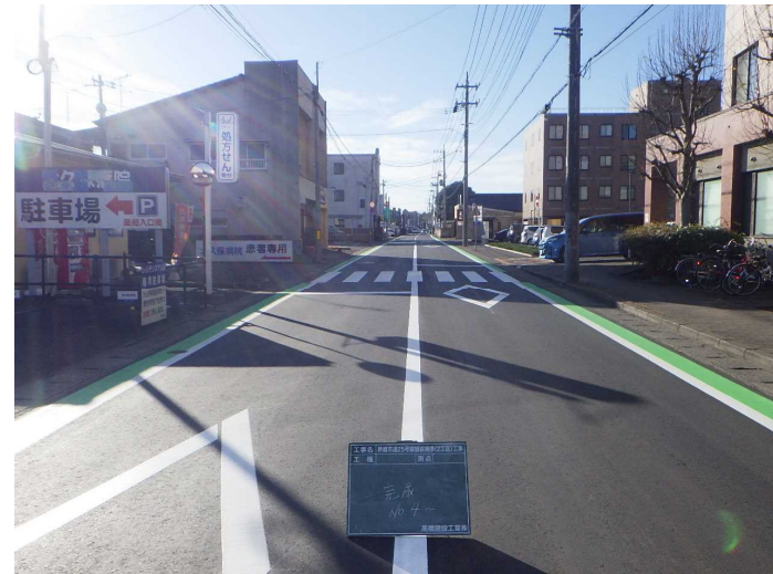
No.16 高橋建設工業(株) 幹線市道25号線舗装補修(2工区)工事
