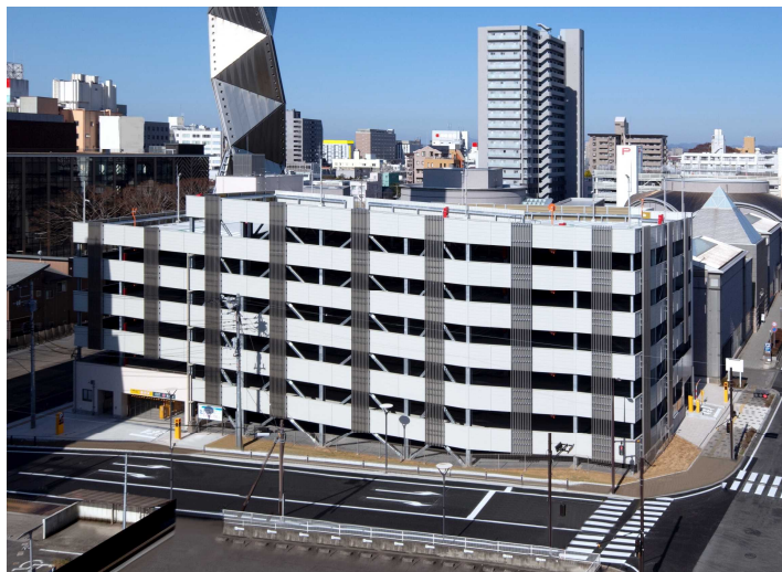
No.9 昭和・葵・関根JV (仮称)水戸芸術館東地区駐車場建設工事
