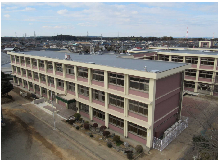
No.19 東洋・西山・関口JV 水戸市立渡里小学校長寿命化改良工事
