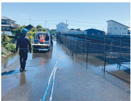
6月の大雨による被害の現場(酒門町)
