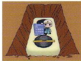
⑩本体据付、水平確認
