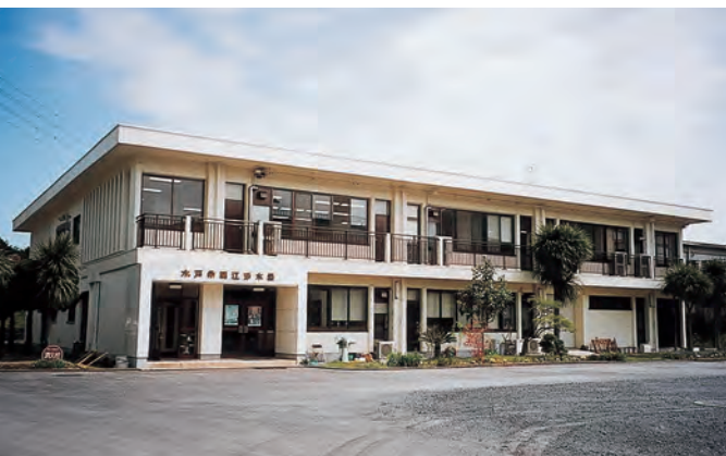
開江浄水場管理本館
