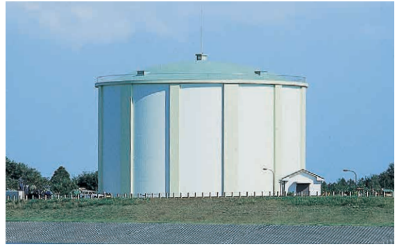
楮川第二配水池 (水戸市内にはこのほかに12の配水池 があります。)
