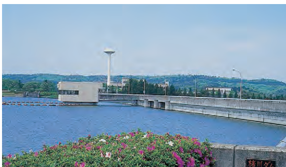
楮川ダム・楮川じょう水場
