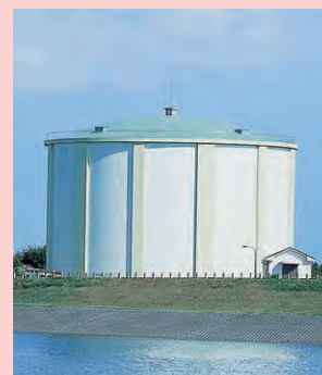
楮川第二配水池
