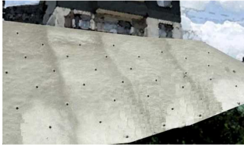
(法面保護：モルタル吹付)
