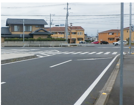
松が丘工区(国道50号接続箇所の交差点)
