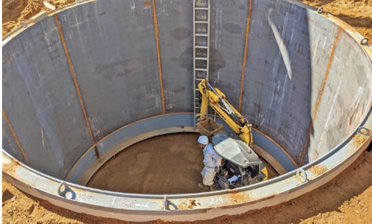
緑岡中学校の耐震型循環式飲料水貯水槽設置工事の様子
