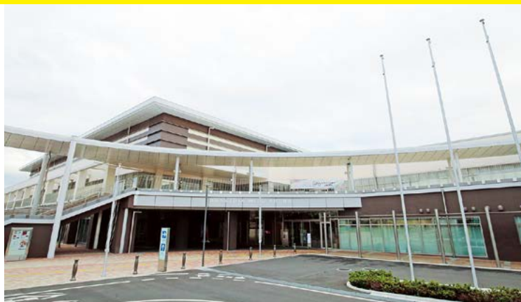
傾斜地を利用した3階建て。回遊性や搬入搬出のしやすさなども考慮されている。
