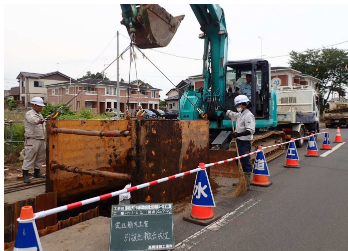
No.19 高橋建設工業(株) 国補公共下水道双葉台処理分区枝線(4-1工区)工事
