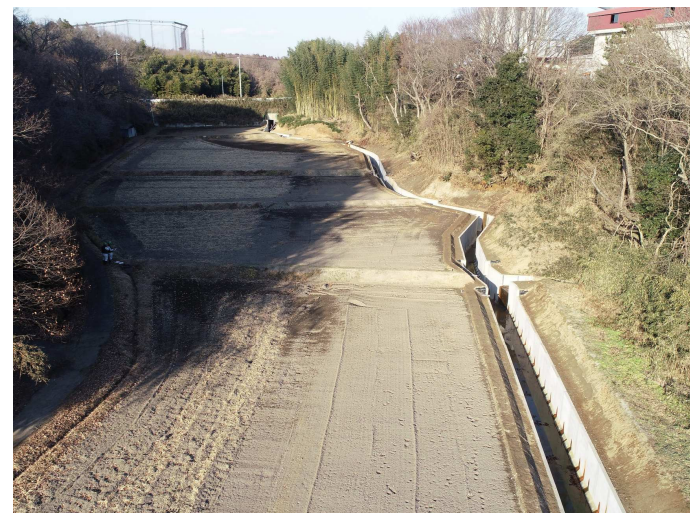
No.12 昭和・アルプスJV 排第9号平須町排水路新設工事(3工区)
