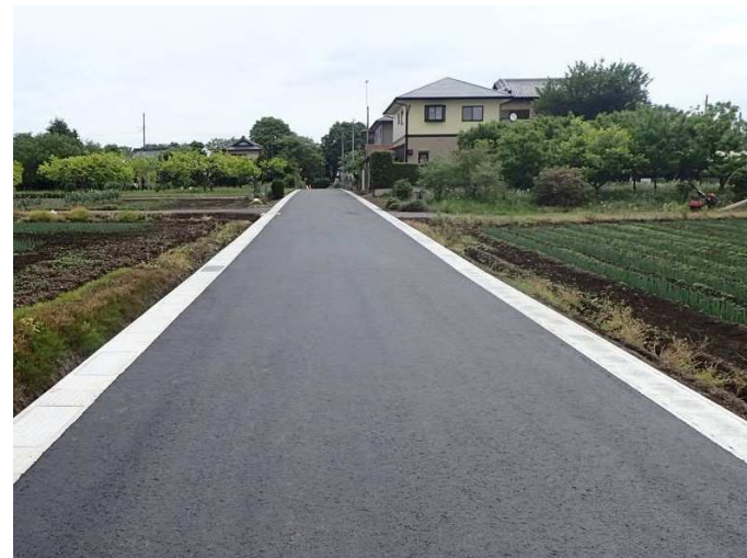
No.26 (株)福田工務店 内原7-0059, 8-0234号線道路改良工事
