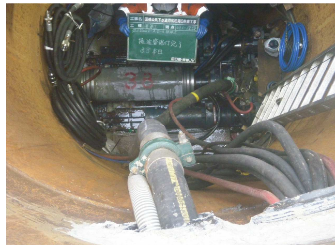
No.22 田口建・常磐JV 国補公共下水道河和田第6幹線工事
