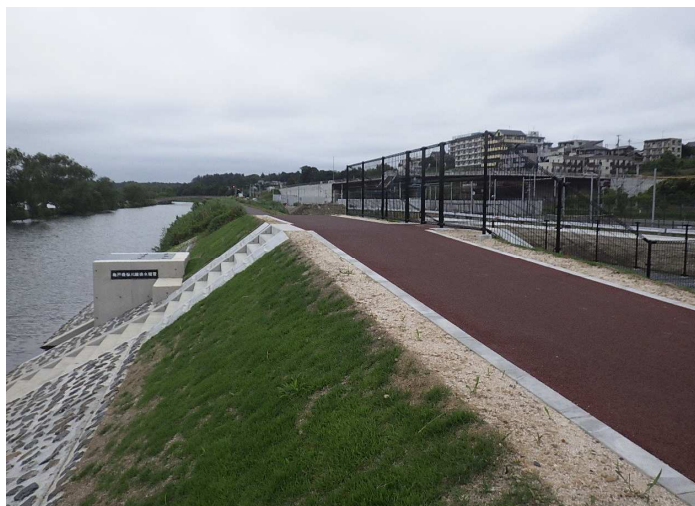
No.21 田口建・市毛建JV 都市計画道路3・3・175号雨水排水設備整備工事
