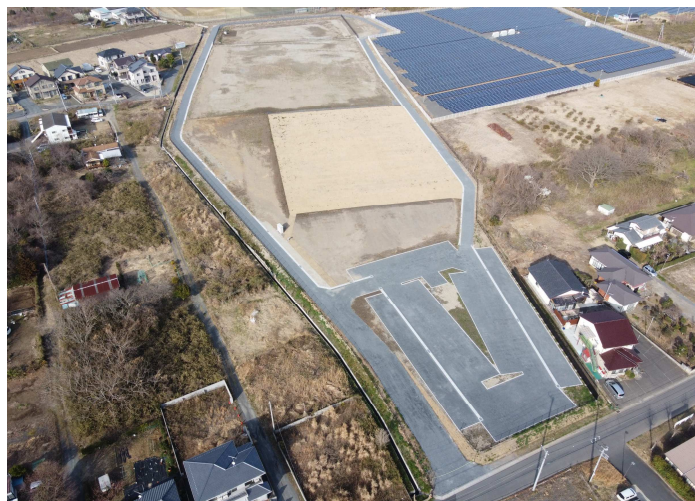
No.3 足立・酒井JV (仮称)西谷津広場整備工事
