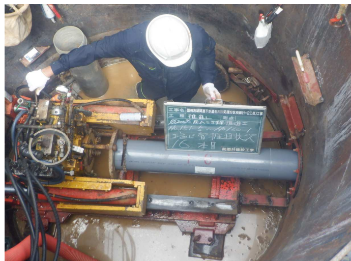
No.10 (有)酒井建設工業 国補流域関連下水道石川川処理分区枝線(1-2工区)工事
