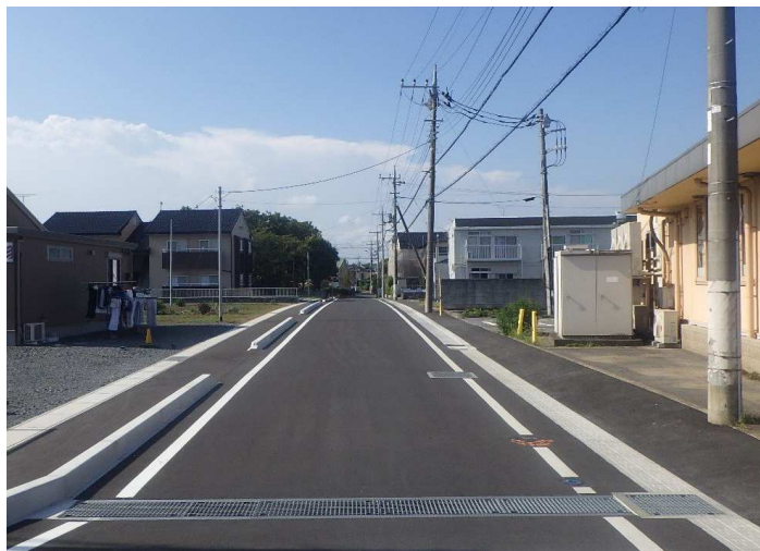
No.5 (有)大山建設工業 上中妻173号線道路改良工事
