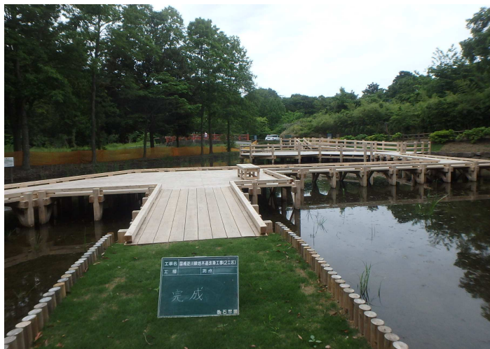
No.17 (株)石翠園 国補逆川緑地木道改築工事(2工区)
