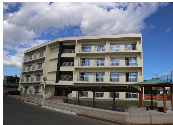
No.18 関根・西山JV 砂久保住宅新築工事
