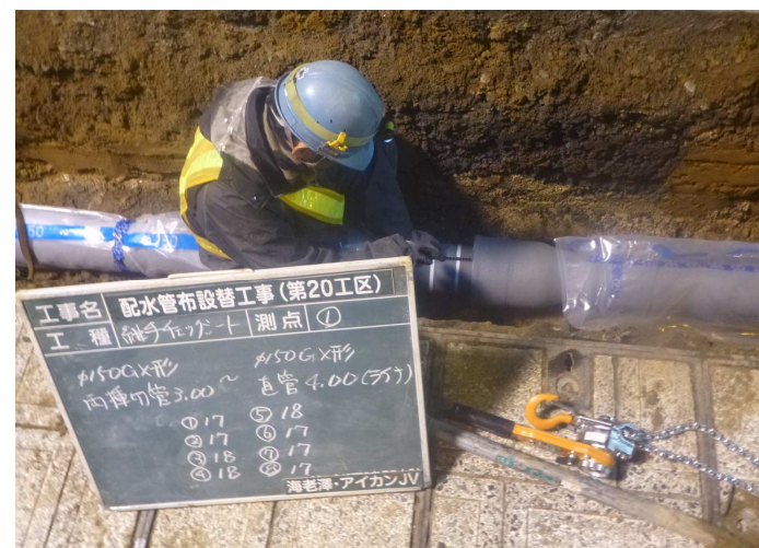
No.4 海老澤・アイコンJV 配水管布設替工事(第20工区)
