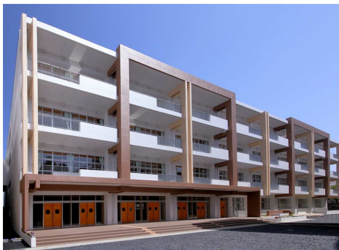
No.9 コスモ・東洋・関口JV 水戸市立見川小学校増改築工事
