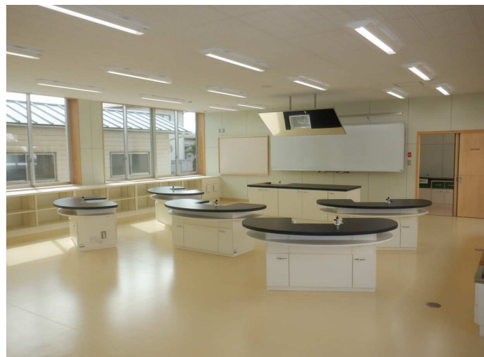
No.11 佐藤電設(株) 水戸市立上大野小学校長寿命化改良電気設備工事
