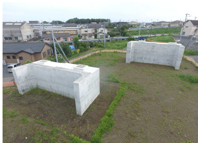
No.2 秋山・上水戸関JV 都市計画道路3・3・2号中大野中河内線(松が丘工区)橋梁下部工(2工区)及び都第12号都市下水路仮移設工事
