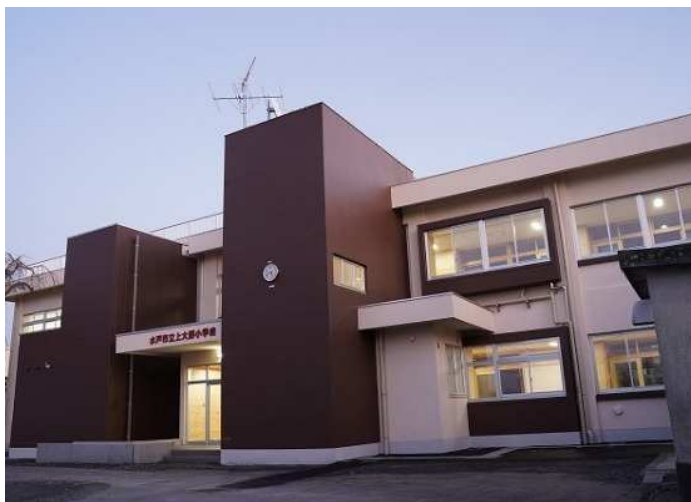
No.1 葵・大内JV 水戸市立上大野小学校長寿命化改良工事
