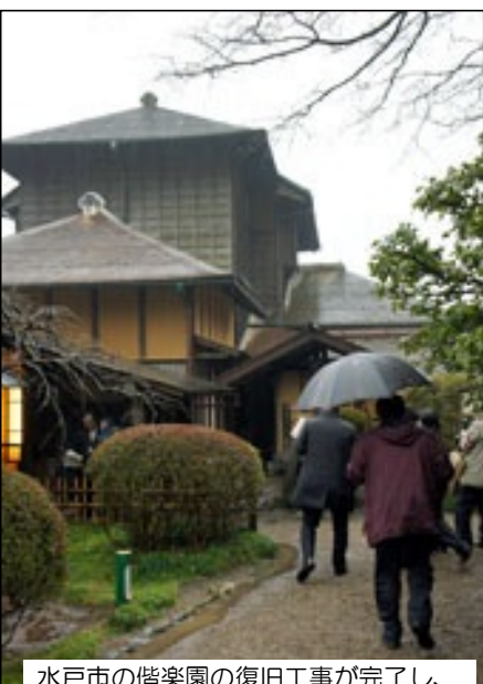
水戸市の偕楽園の復旧工事が完了し、公開された「好文亭」
