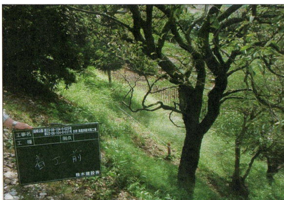
南崖地割れ① 着工前
