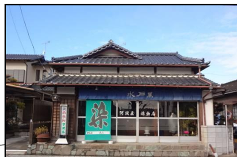
屋根の葺きかえを実施
