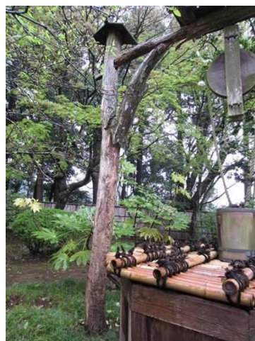
④井戸屋形の補修箇所写真
