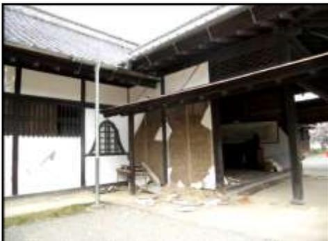
復旧前 屋根椽瓦のあばれ、内外壁に剥離・落下・亀裂が生じるとともに、建具が損傷した。
