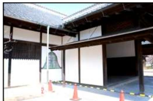
復旧後 在来工法により、屋根瓦の葺替・補修、壁の塗り直し、耐震補強を行い、震災前の状態に戻した。
