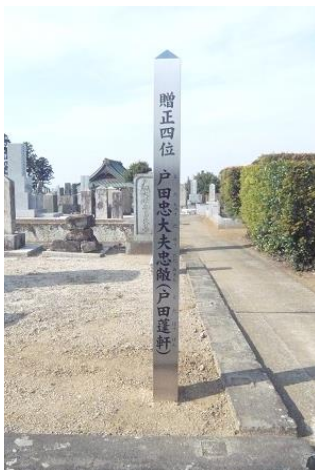
木柱修繕(酒門共有墓地)
