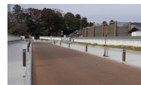
整備後(白壁塀・歩道等整備)
