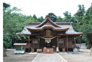
八幡宮拝殿及び幣殿修復後
