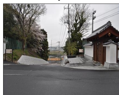
整備後(道路・白壁塀・城門整備)
