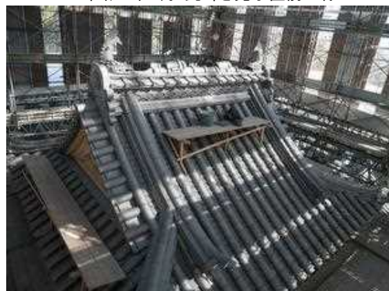
令和2年3月:瓦葺き完了直前の様
