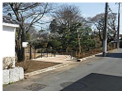
施工中 (R3年度完成予定)
