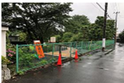
施工箇所 施工前
