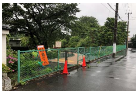
施工箇所 施工前
