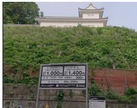
施工後(茶色ベースに改修)
