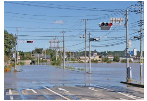
【台風による浸水】
