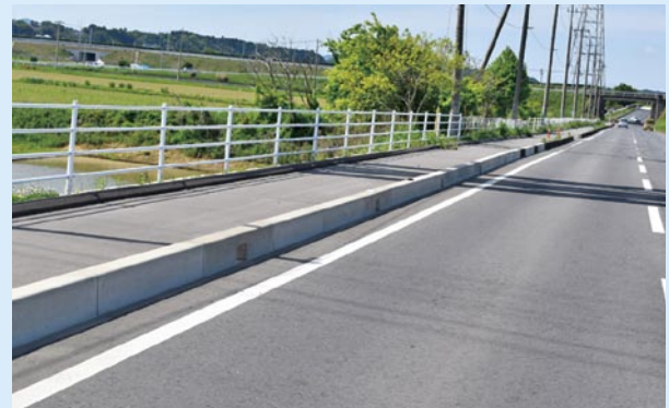
耐震管へと生まれ変わっています
