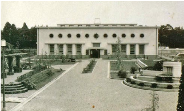
建設当時の芦山浄水場
