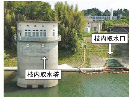
【枝内取水塔・取水口】
