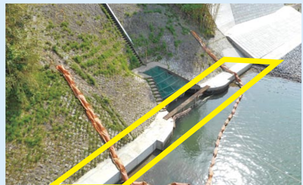
護岸を復旧しました
