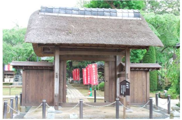
建造物 六地藏寺四脚門（県指定）
