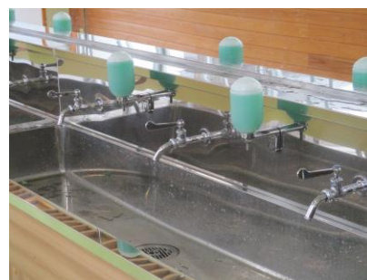
レバーハンドルの設置
