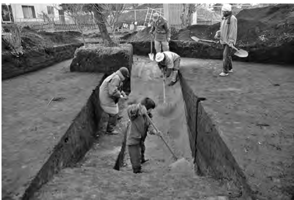
挿図写真5 第13トレンチ埋め戻し風景
