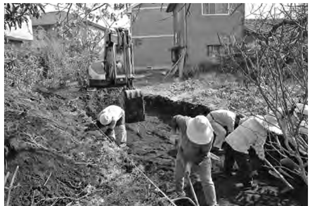
挿図写真2 第13トレンチ表土掘削風景
