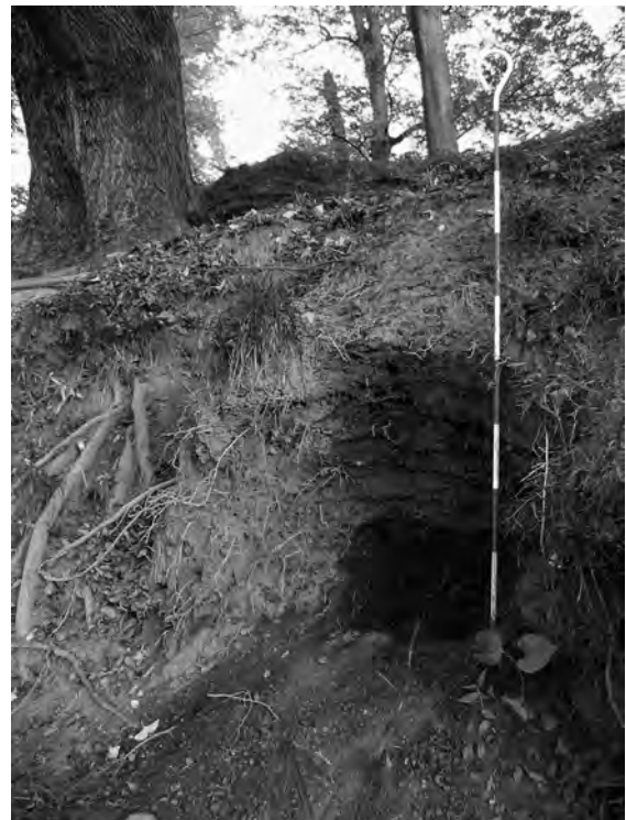
挿図写真6 版築断面状況
