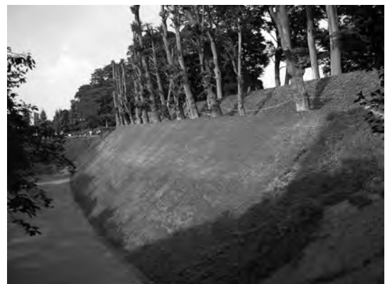
挿図写真4 竣工後の状況
