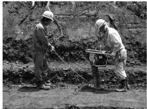
挿図写真3 転圧工施工状況
