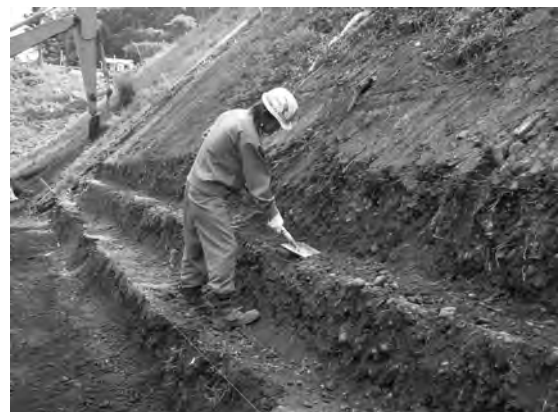
挿図写真2 段切り工施工状況
