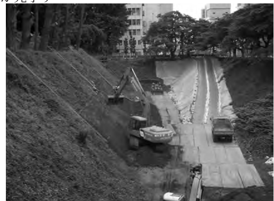
挿図写真1 仮設搬入路と濠底仮設路敷設状況
