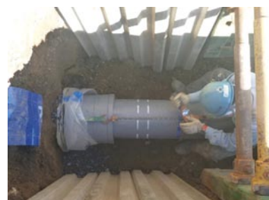
(口径300mmの耐震管を敷設している様子)
