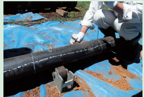
管路診断・調査
