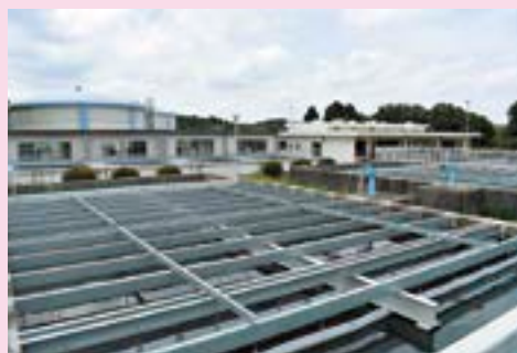
ひらく えいじょうすいじょう 開江浄水場
