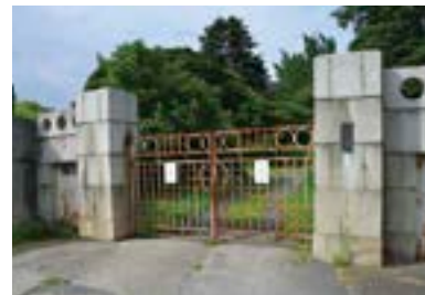
芦山浄水場正面門
