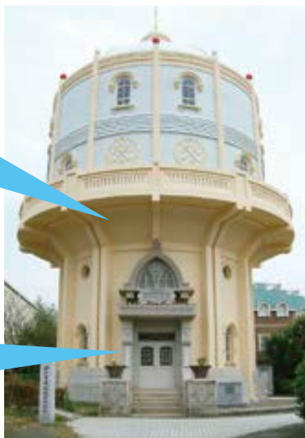
低区配水塔外観
