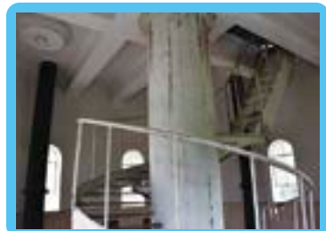
普段見ることのできない 塔内部の様子
