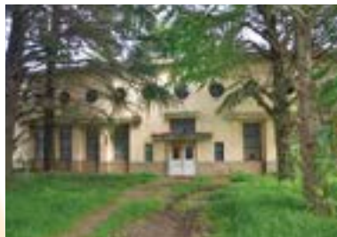
芦山浄水場外観
